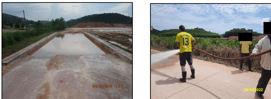
ภาพที่ 2.9 บ่อล้างล้อรถบรรทุก และฉีดทำความสะอาดถนน
